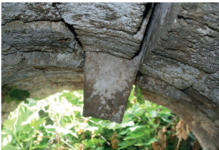
Arco de c/ Conde de Superunda. Bóveda vencida con deslizamiento de dovelas.
