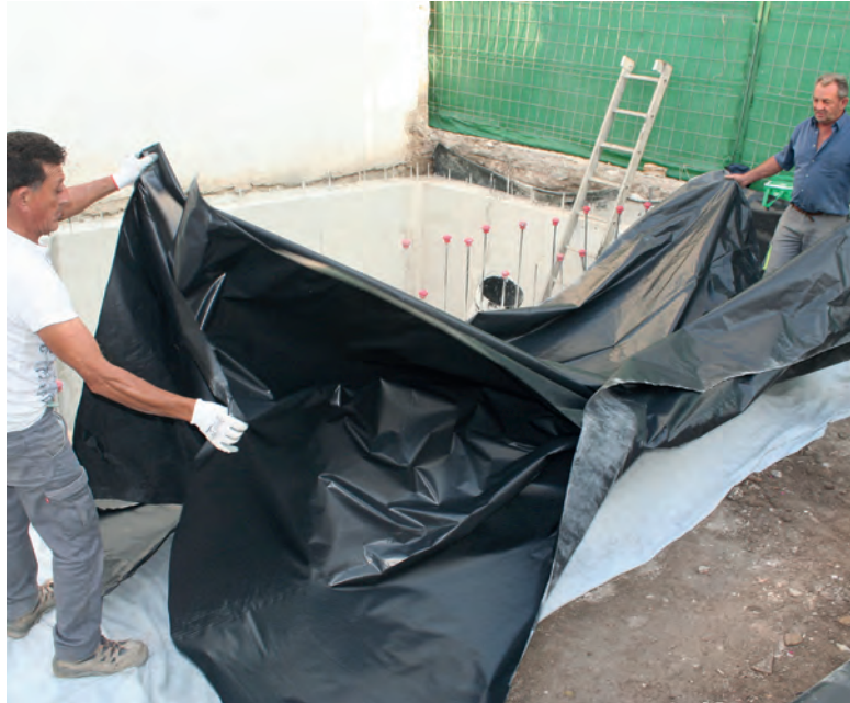
C/ Real, 55. Protección de estructuras medievales.
